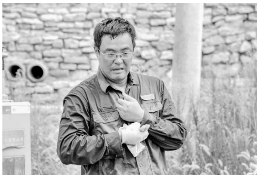
尽管天已入秋,但气温仍居高不下。为保障城乡居民可靠供电,国网东平供电公司员工顶烈日、冒高温进行带电作业,向广大电力客户诠释“不停电就是最好的服务”的供电承诺。(孔琳 张思凯)
