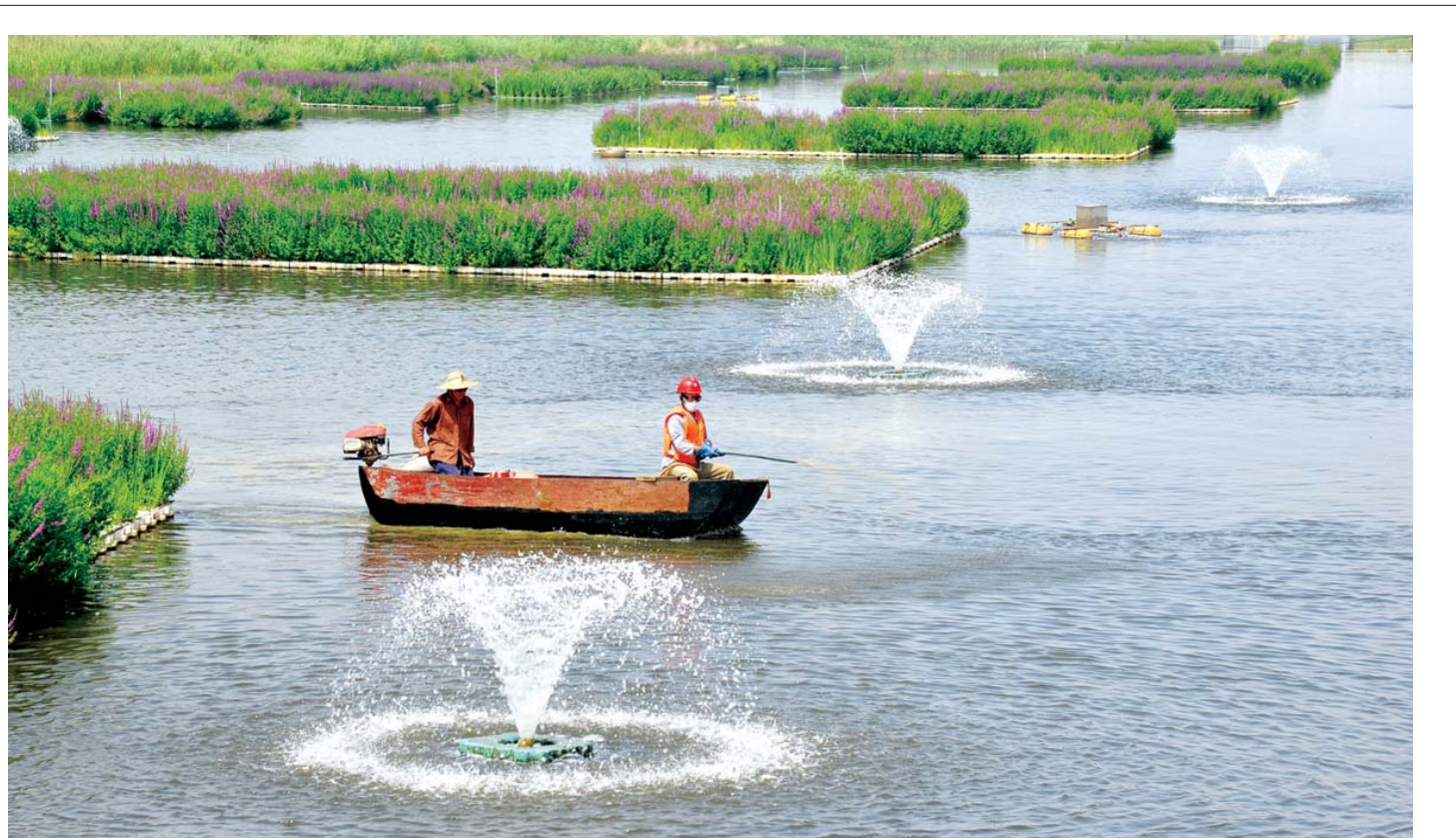
日前，在东营市东营区老广蒲沟黄河路街道段，环保工作人员正在向水中喷射絮凝剂等高效环保微生物菌剂，净化水质。近年来，东营区紧密结合上级环保部门治污工程，多措并举，持续开展河道生态治理，通过搭建人工生物浮岛、种植净化水生植物、架设增氧机、实施人工曝气、高效环保微生物菌剂投加等一系列措施，有效抑制河道黑臭和藻类生长，进一步改善水质，积极为广大居民营造优美的水环境。
