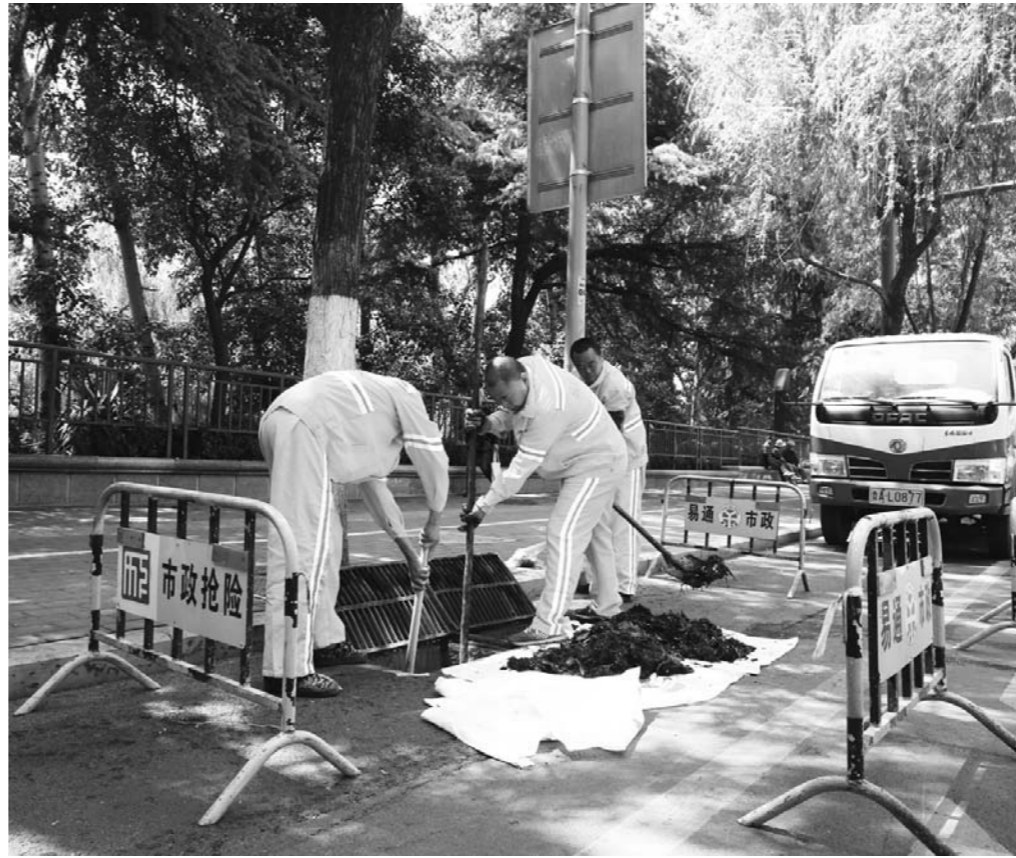
历下区市政局工作人员正在进行市政管网清挖疏浚。
