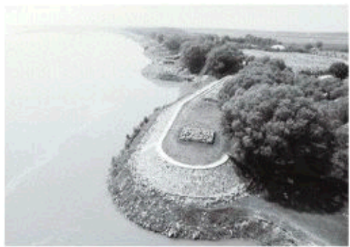
△现代黄河堤防整治工程
