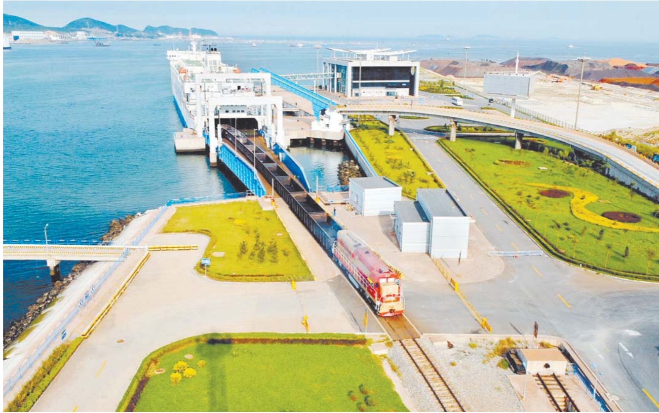
5月8日，在中铁渤海铁路轮渡港区，一列满载货物的列车经过铁路栈桥，缓缓驶入轮渡火车舱。该轮渡主要服务于烟台至大连的货运列车及旅客、汽车运输，是中国第1条、世界第35条海上运输距离超过百公里的铁路轮渡航线。
