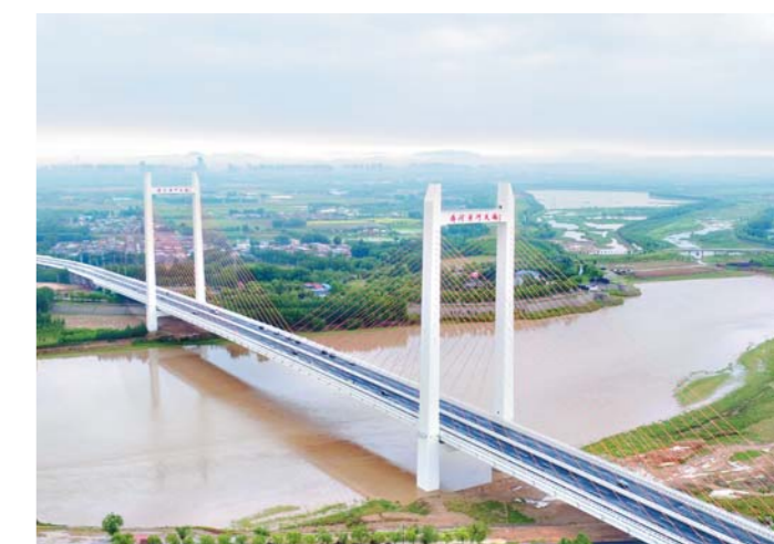
5月16日,齐河黄河大桥通车投入运营。
