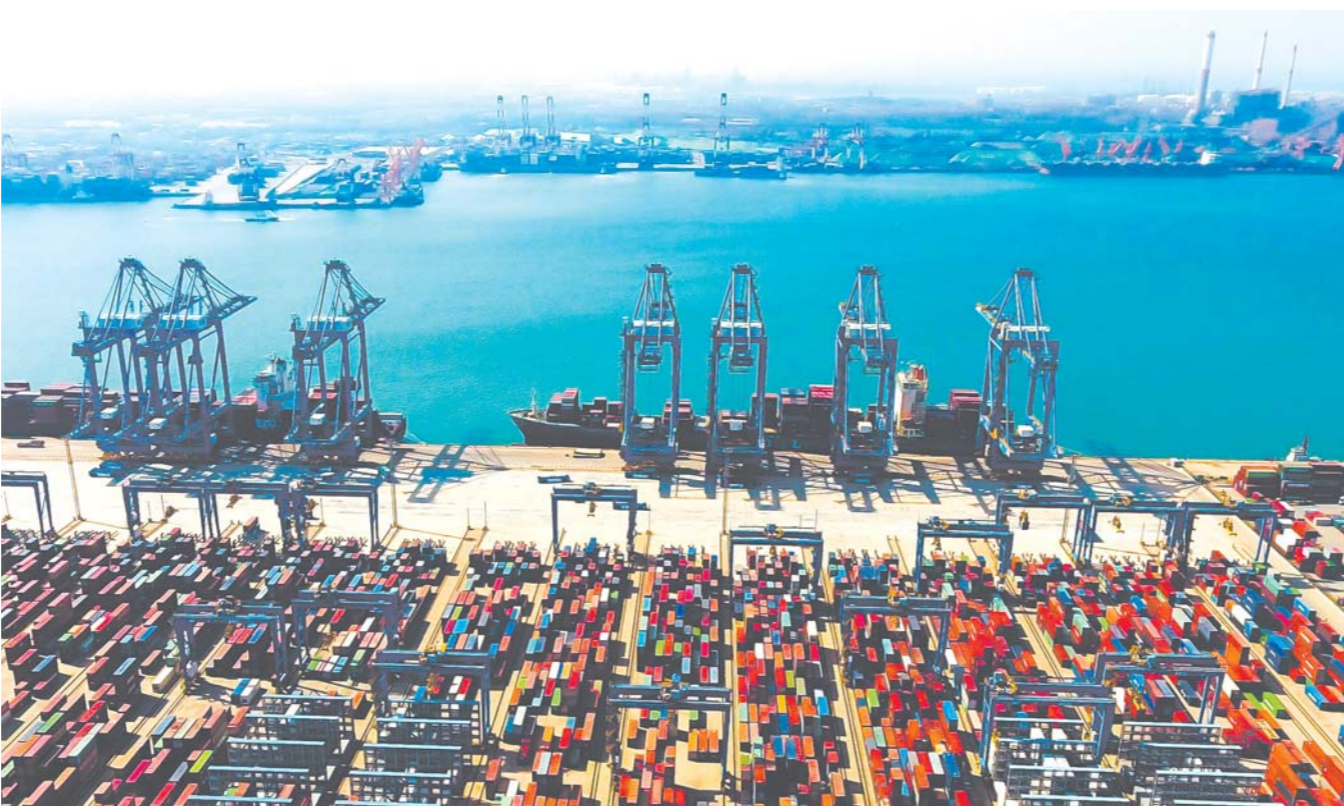
5月4日无人机拍摄的青岛港前湾自动化集装箱码头。(□新华社发)
