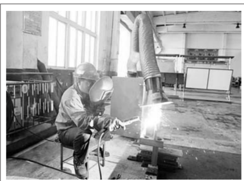
4月24日,在山东能源临矿集团古城煤矿机修车间,一名工人正在进行焊接作业。随着火花飞溅,烟气没有四处扩散,而是顺着管道直接吸入了排烟过滤除尘净化器,此举最大程度地减少了对工人健康的危害。古城煤矿坚持源头防尘立体化、高温治理多元化、噪声防控精细化、“一通三防”规范化、辐射源管理制度化,建矿17年来,未发生一例职业病病例。(陈宜勇 左丰歧)
