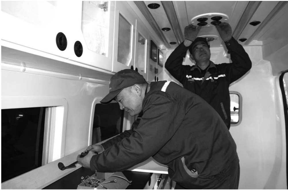
在正泰希尔改装车间，工作人员正在房车内进行电路安装。
