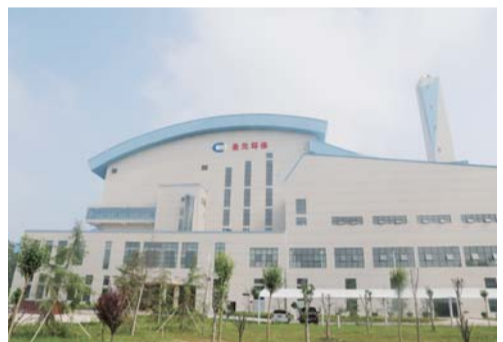
△郓城县生活垃圾焚烧发电项目已投入生产
