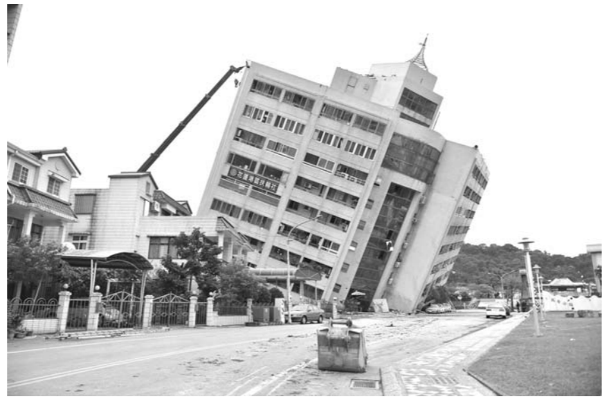
△倾斜倒塌的云门翠堤大楼(2月7日摄) □新华社发
