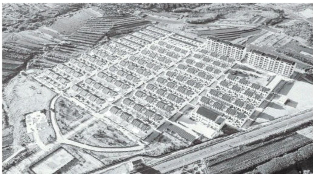
△东港区南湖镇弓山村易地搬迁项目
