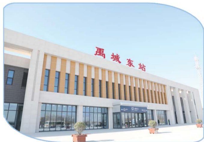
△石济客专禹城东站投入使用
