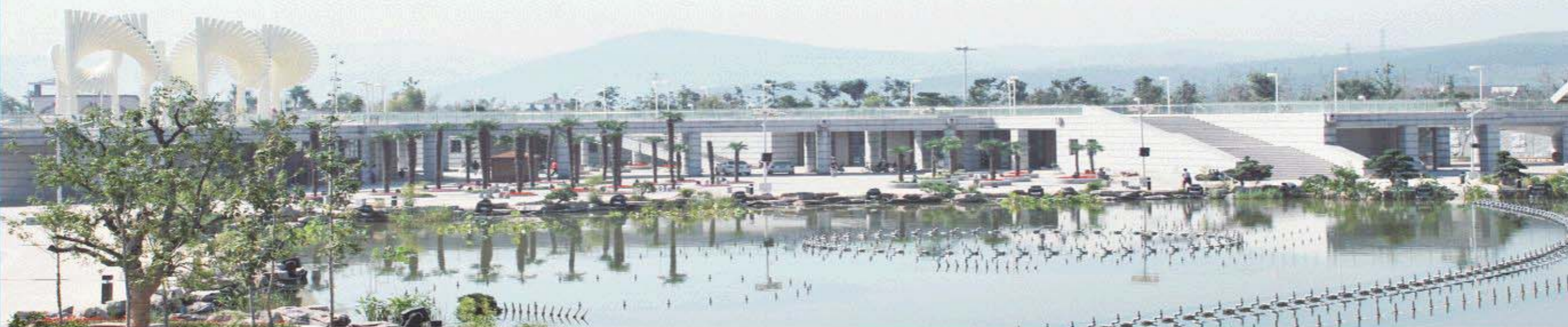
△第七届中国(济南)国际园林花卉博览会园工程荣获2010年度中国建筑工程质量最高奖——鲁班奖,并先后获得泉城杯、泰山杯、新中国成立60周年山东省精品建设工程、改革开放35年百项经典暨精品工程等荣誉
