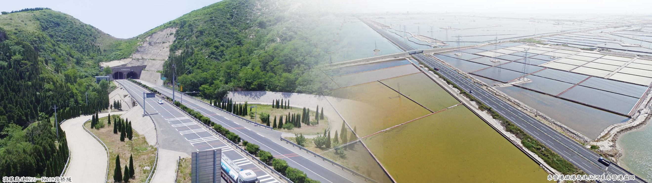
潍莱高速K90—K108段桥隧
