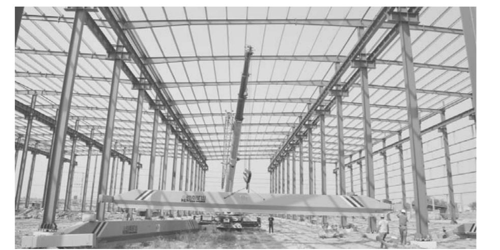
通过北京招商落地的志峰环保项目正在紧张施工。
