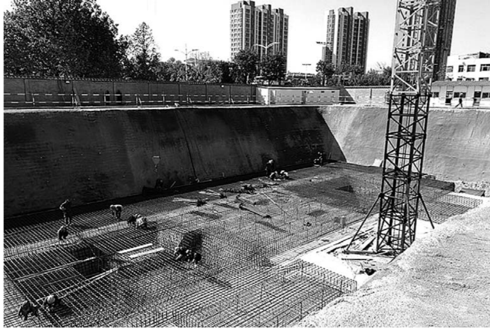
□记者 都镇强 通讯员 张平 报道 图为昌乐北关片区新建安置房项目施工现场。项目已于去年8月份开工建设。
