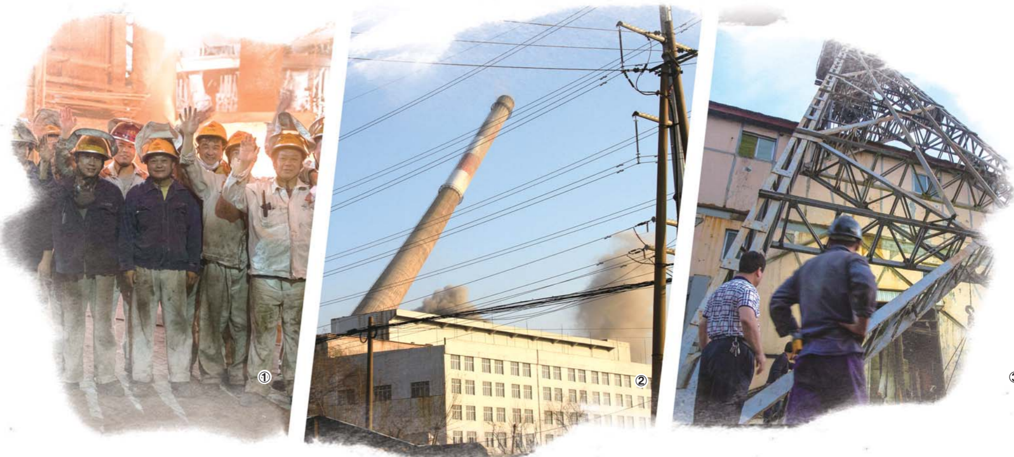
图①：山钢集团济钢炼铁厂3号1750立方米高炉最后一炉。图②：聊城信发集团烟囱实现成功爆破。图③：枣庄陶庄煤矿正在拆除升降矿井设备。（资料片）
