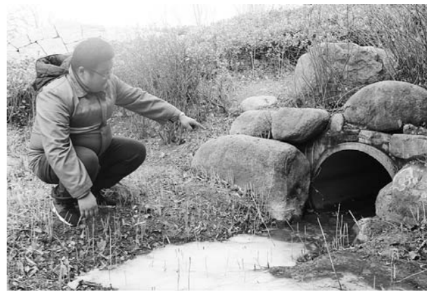
□记者 张晓帆 报道 近日，青岛市李村河巡河员张华帅在巡查雨水管道。
