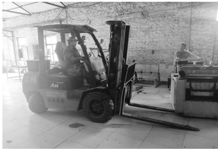
淄博鹏泽塑料制品有限公司拆除厂区生产设备。
