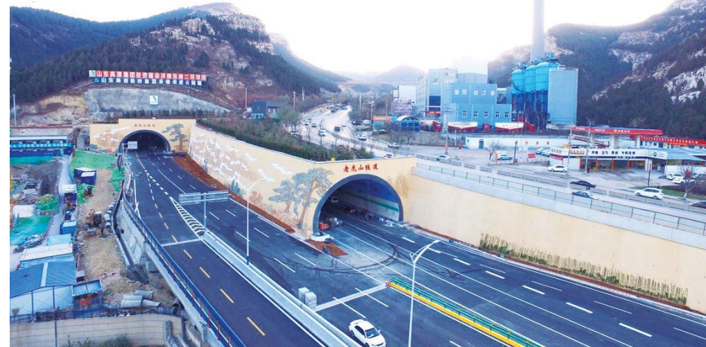
济南老虎山隧道群。
