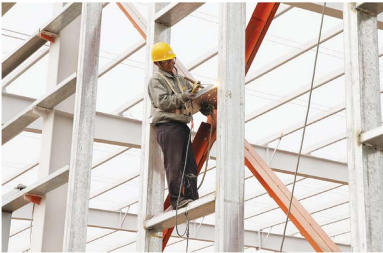
在青特项目建设现场，工作人员正在对部分主体框架进行加固焊接。
