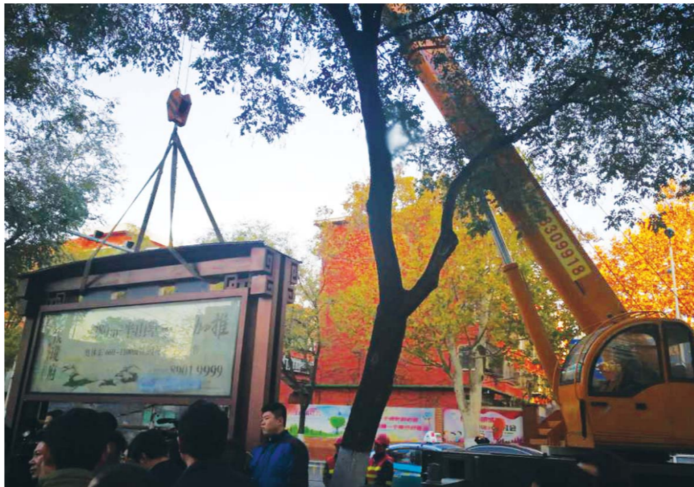
11月23日，在青年东路，施工机械正在拆除一处违法广告牌。
