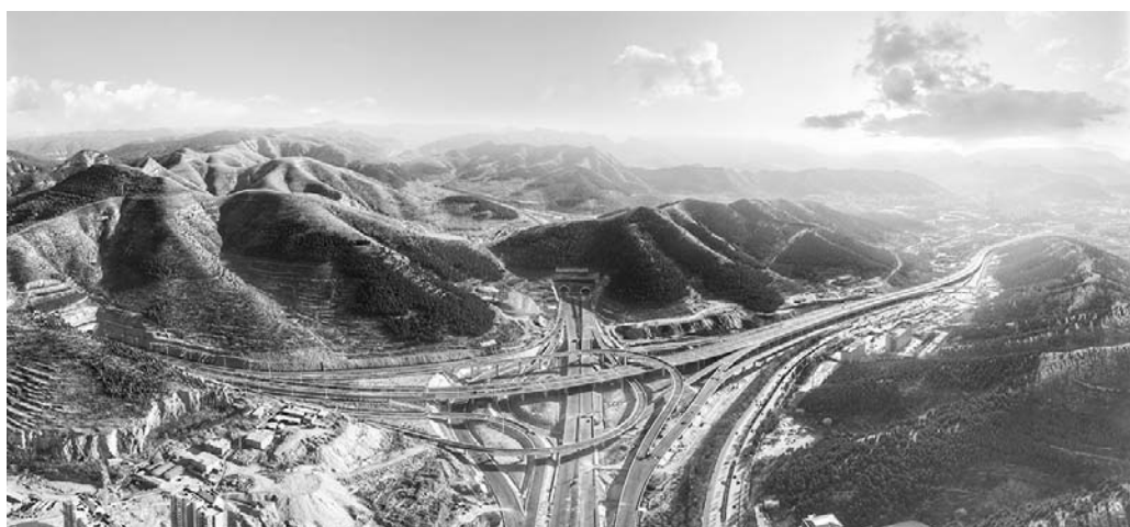
△济南二环东南延项目立交，一桥连三隧
