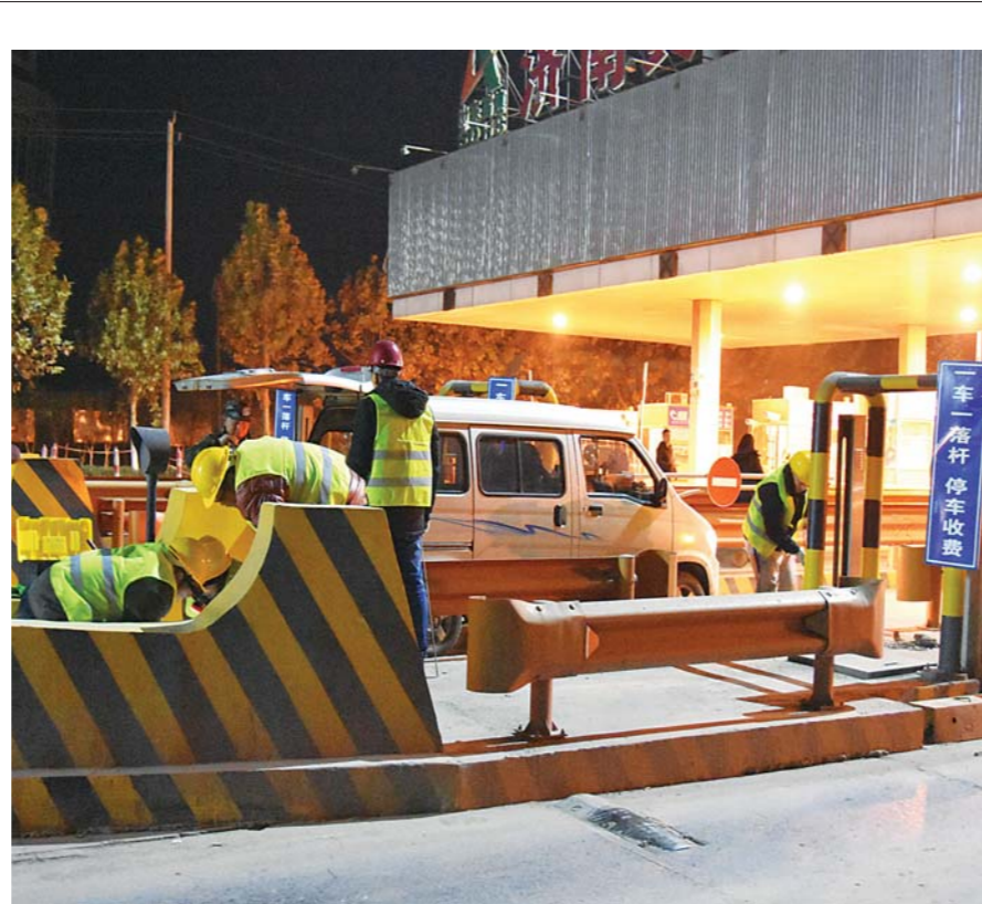
□记者 陈明 报道 11月16日凌晨,工人在拆除济南黄河公路大桥收费站设施。
