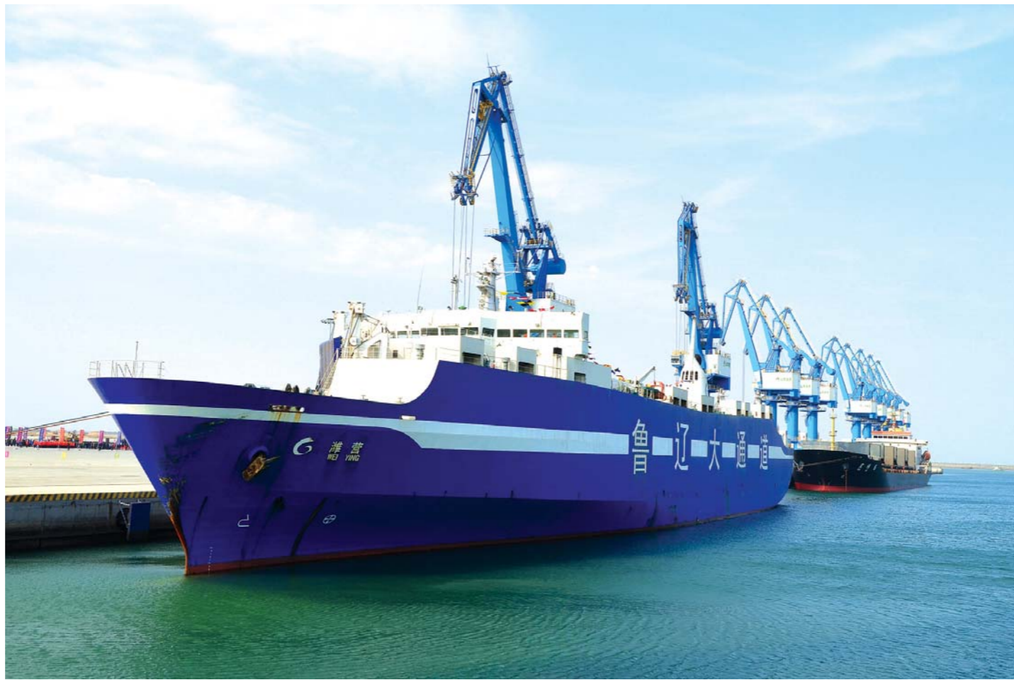
11月9日，山东高速潍坊港开港运营。图为鲁辽挂挂运输船“潍营号”停靠客货滚装泊位。
