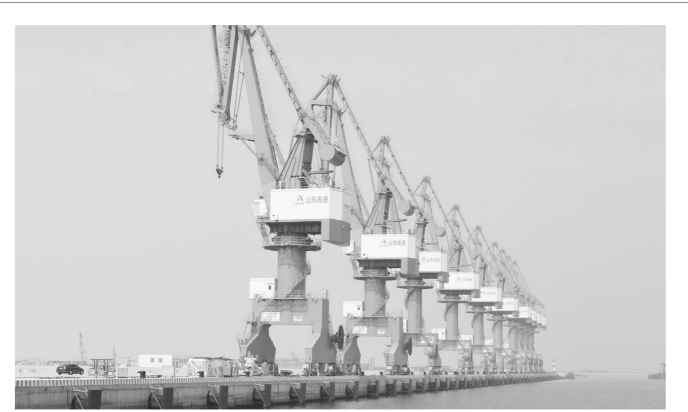
山东高速潍坊港开港运营
