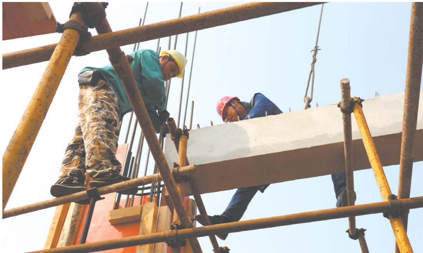
图为岚山一中新建教学楼工程施工现场。
