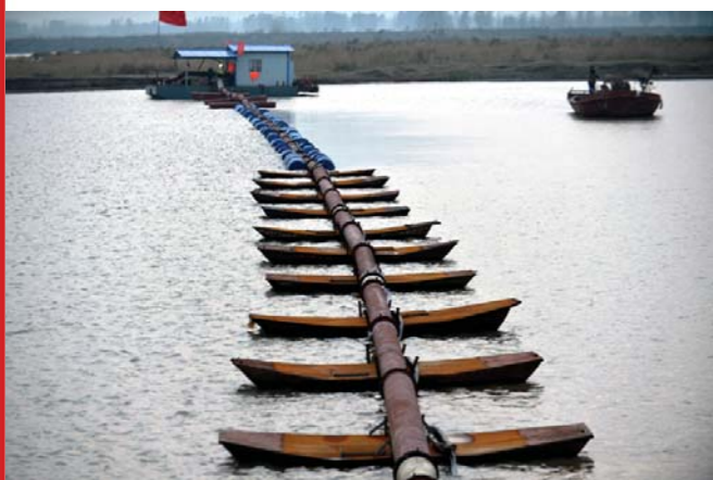
东明县长兴集乡，黄河河道中，连接管道的船只正在抽取用于8号村台施工的泥沙。(吴宝书 卢鹏 摄)
