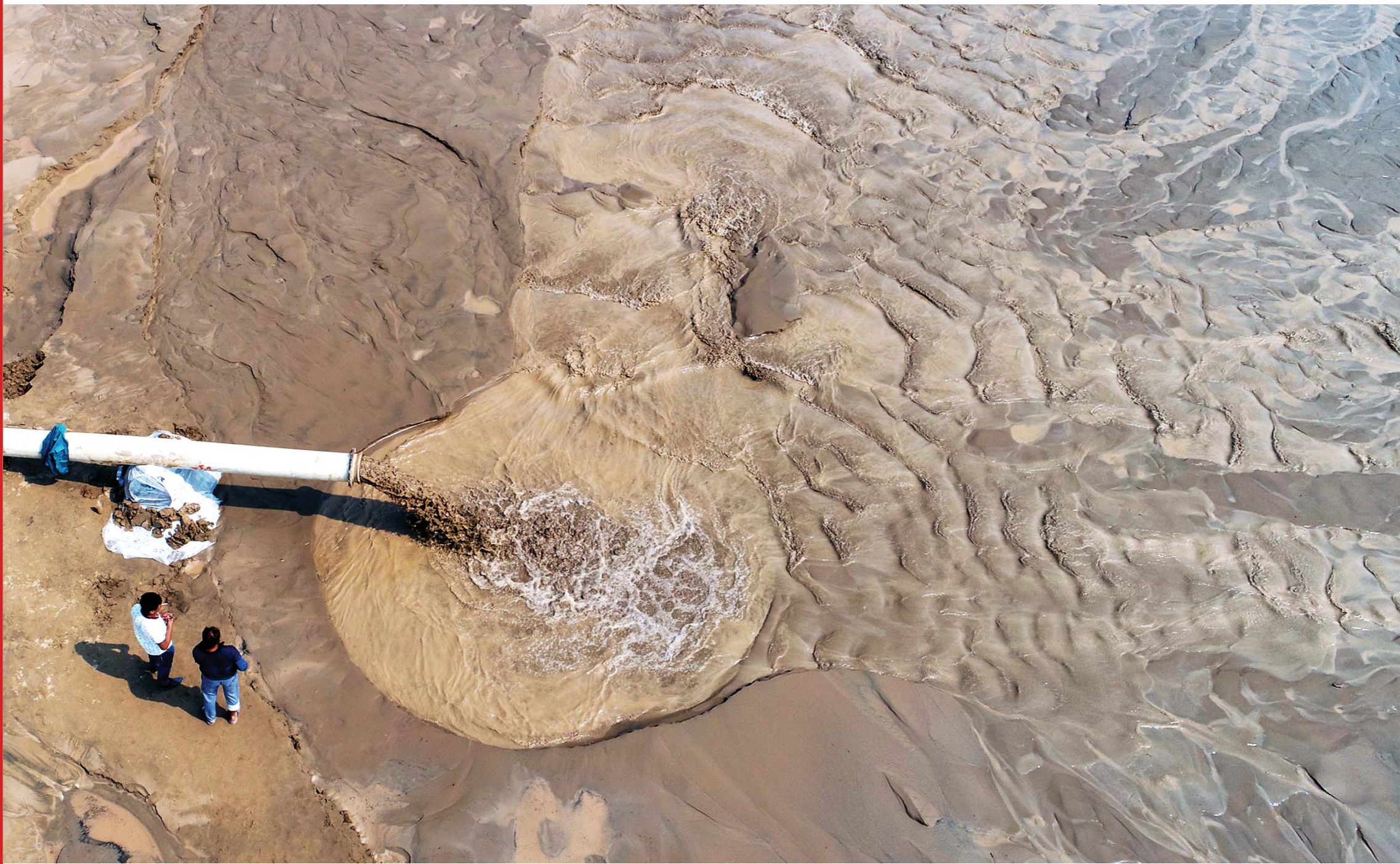
菏泽市东明县焦园乡8号村台施工现场，设计面积近800亩、高度4米的村台主要由从黄河中搅动抽出的泥浆流淌淤积而成。(卢鹏 刘庆恩 摄)
