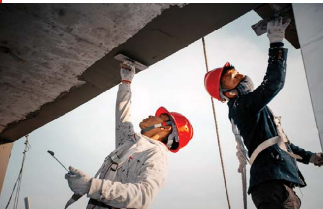
正在施工中的东平县耿山口社区。该社区全部框架、框剪结构，可抗8级以上地震，施工材料和环节全都严格把关。(王世翔 张越 摄)
