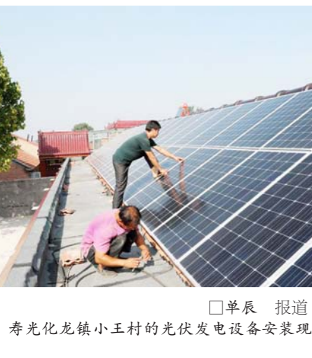
□单辰 报道 寿光化龙镇小王村的光伏发电设备安装现场。
