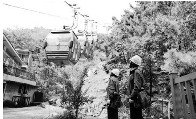
9月27日，国网蒙阴供电公司桃墟供电所的4名员工在蒙山旅游景区按照各自分工，对10千伏雨王线、蒙山索道、涉及的宾馆饭店，进行一次系统检查消缺，确保节日期间供电安全。
