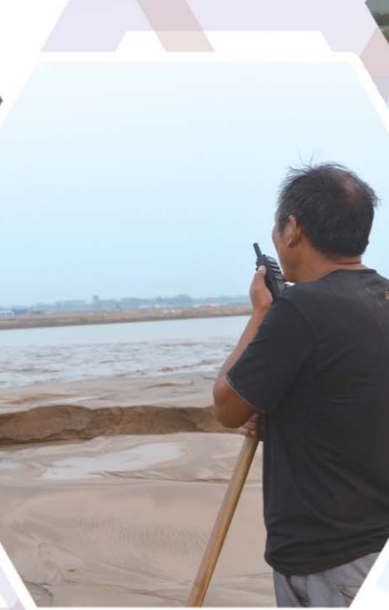
□记者 卢鹏 报道 东明县焦园乡8号村台施工现场，工人正用对讲机通报管道输出泥浆情况
