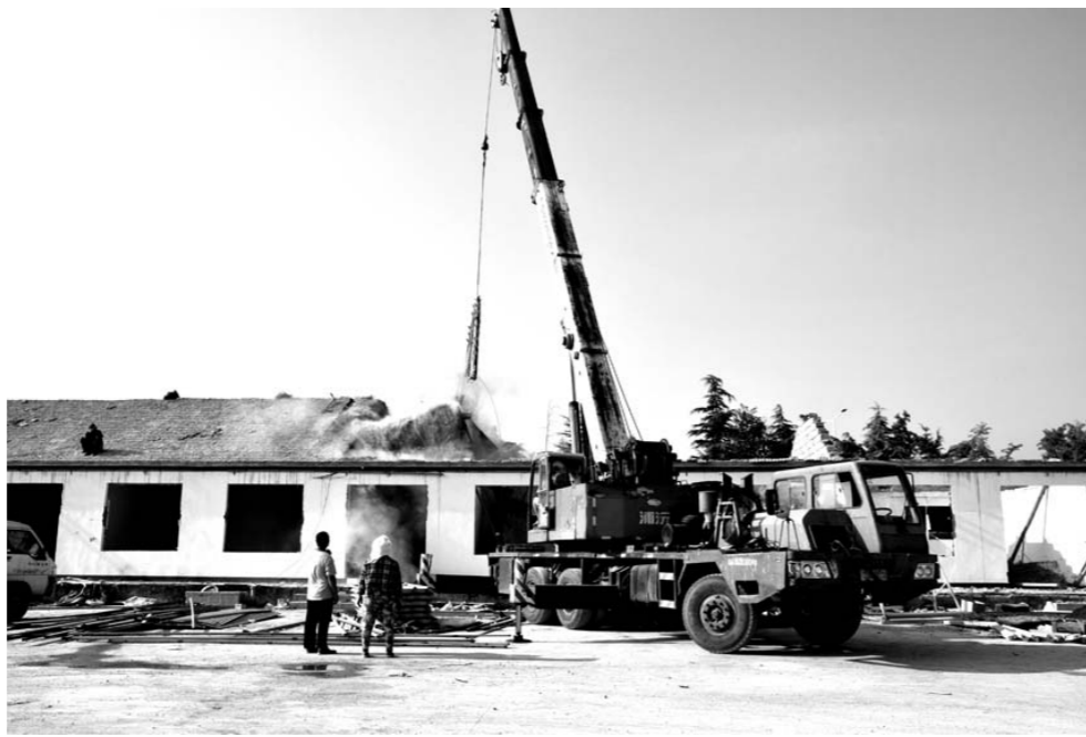
□ 通讯员 张磊 报道 昌乐县首阳山区域违建拆迁现场。该区域通过20天的集中行动，全面完成拆违任务。
