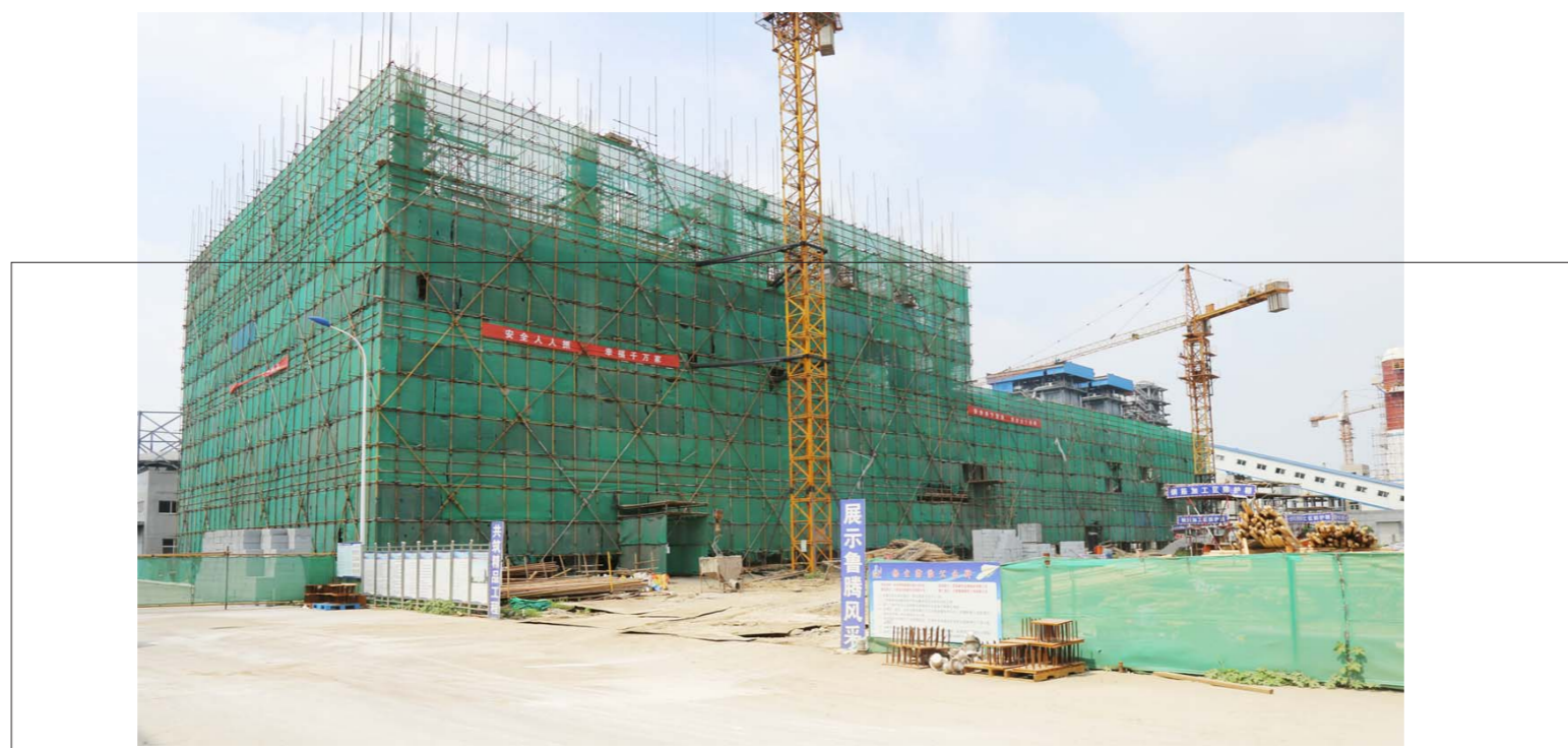
□记者 栗晨皓 通讯员 孙立国 报道 8月24日，走进莒县金禾博源年产14万吨精品柠檬酸项目建设现场，只见车辆往来穿梭，塔吊挥臂作业，工人们忙上忙下……今年以来，莒县狠抓重点工程、重点项目建设，通过持续扩大有效投资促进县域经济快速发展，掀起振兴工业热潮。
