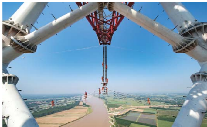
△国网山东电力员工在榆横—潍坊1000千伏特高压黄河大跨越进行工程验收工作。
