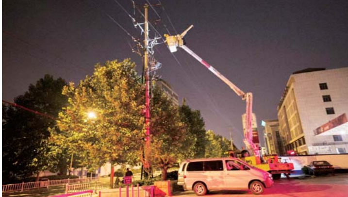
△国网泰安供电公司利用深夜负荷低谷时段，积极对设备开展“零点”消缺、“零点”抢修
