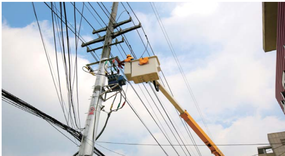
△国网泰安供电公司工作人员冒着34摄氏度的高温对10千伏高新线25杆电缆T节点发热缺陷开展了带电消缺作业
