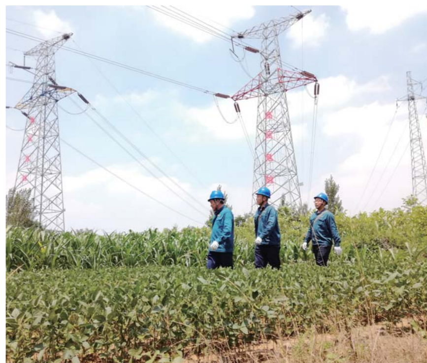
△国网泰安供电公司输电运检室工作人员穿越农田巡视供电线路
