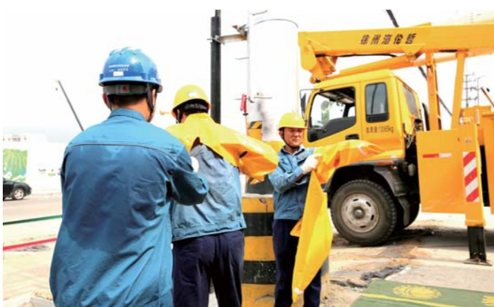
△国网泰安供电公司带电作业人员身穿绝缘服汗流浹背准备上杆作业
