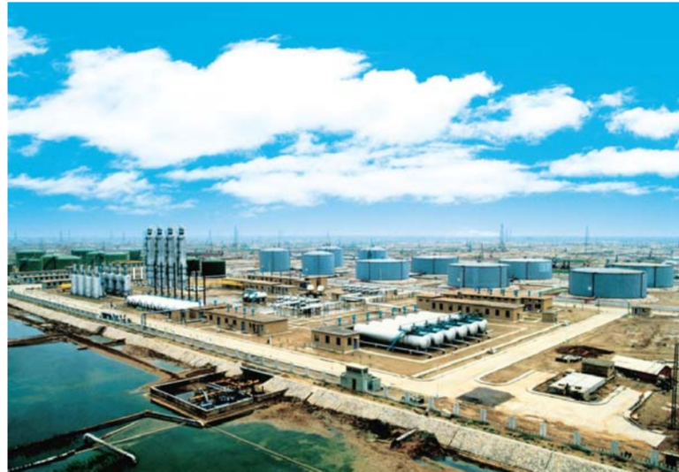
△孤东一号联合站全景
