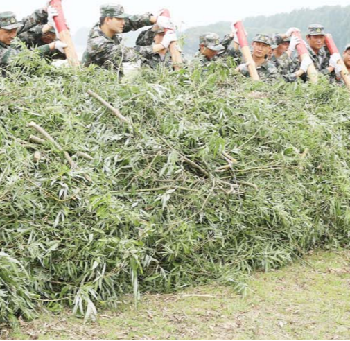
河口黄河专业抢险队正在黄河八连控导工程紧张进行捆抛柳石枕演练。
