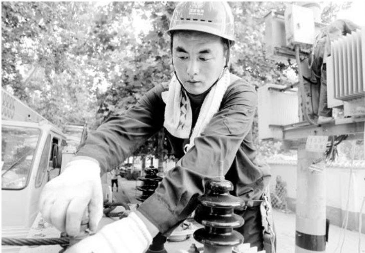
7月11日，聊城市10千伏东昌II线133#公变因用电负荷过大导致停电，国网聊城供电公司员工不顾高温赶到现场开展抢修工作。（赵蓁 左丰歧）
