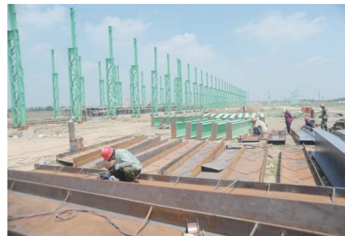
△发挥钢铁支柱产业的资源优势，建设国家级钢铁产业转型示范城市。图为正在建设的泰钢集团泰嘉80万吨冷轧不锈钢项目工地现场。
