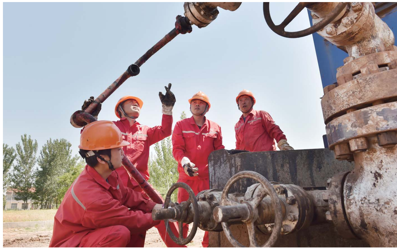
近日，在滨509—斜50井场，胜利油田鲁胜公司鲁丰采油管理区员工利用网井间隙，提前安装放喷管线。
