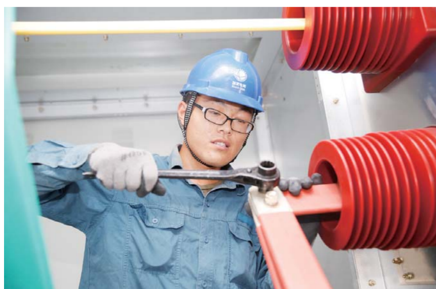
△7月10日，莱西市供电公司运维检修班工作人员在高温酷暑中为北汽新能源国轩电池高压室内设备进行检修
