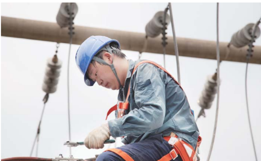
△7月4日，枣庄供电公司工作人员在高温下对110千伏朱山变电站设备进行检修
