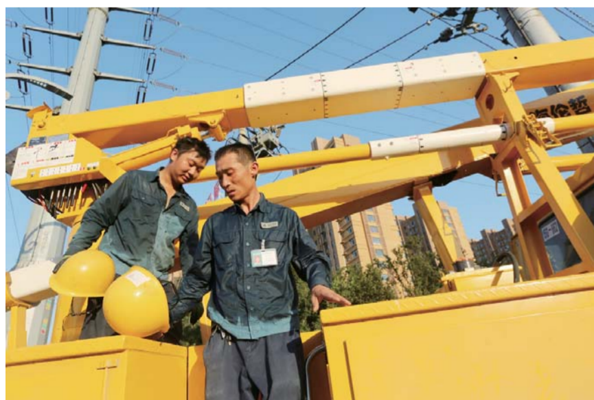
△7月8日下午6时，聊城供电公司工作人员完成了聊城市10千伏柳东I线农校支线1#杆带电更换柱上开关工作，从绝缘斗臂车上下来时，工作服已被汗水浸透
