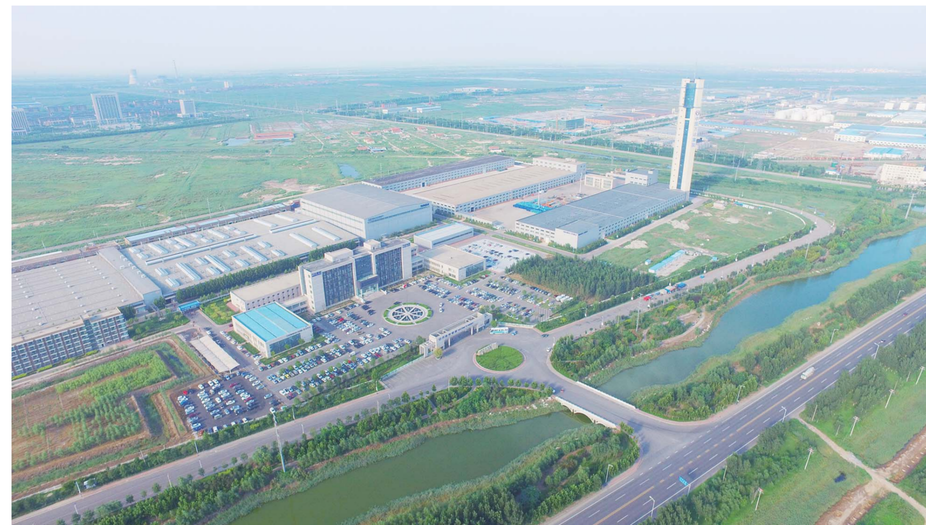
△万达电缆厂区俯瞰图
