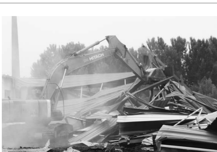
唐冶街道奶牛场拆除现场。
