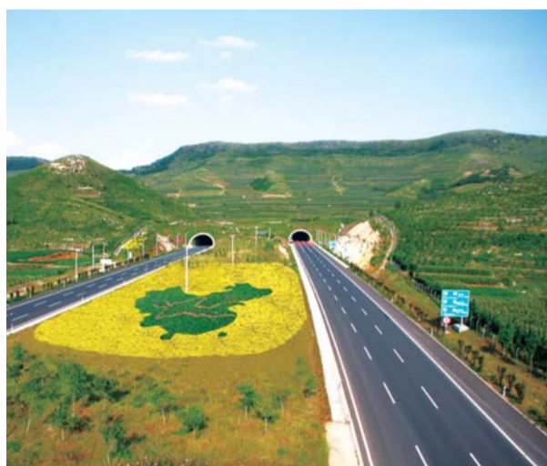
△G22青兰高速公路临沂段
