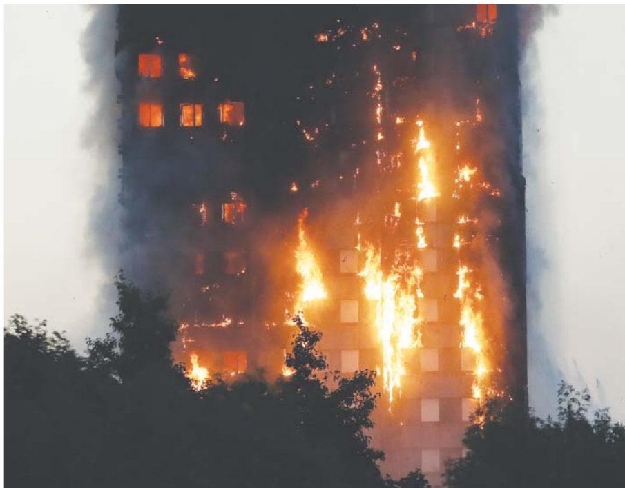
这是6月14日在英国伦敦拍摄的起火公寓楼。英国伦敦一高层公寓楼14日发生火灾。英国警方14日说，居民楼的大火已造成至少6人死亡，已有约50人被送往医院接受救治，死亡人数可能进一步上升。截至当地时间11时30分，大楼明火已被扑灭，起火原因仍在调查之中。
