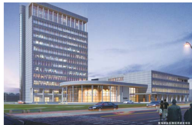
△正在建设中的登海种业(青岛)高新技术研发中心
