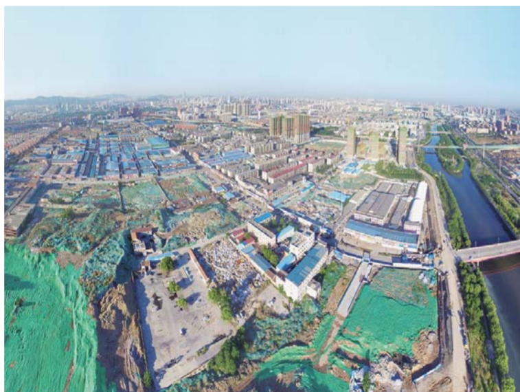
△北湖片区拆除地块航拍图
