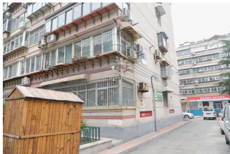
△东二区楼房线路落地后对比
