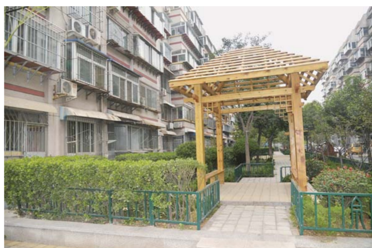
△大明湖小区东二区整治后
