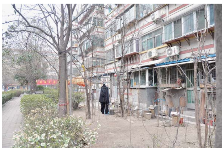
△大明湖小区东二区整治后
