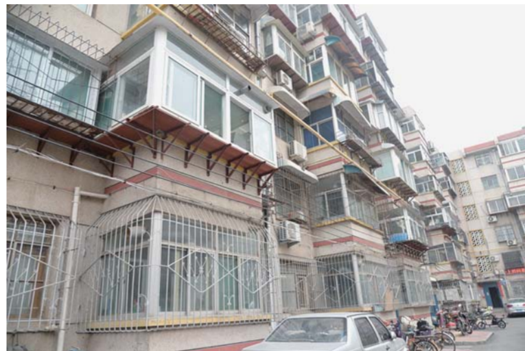
△东二区单元之间线路落地后
