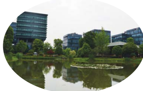
▲杭州未来科技城外景。
